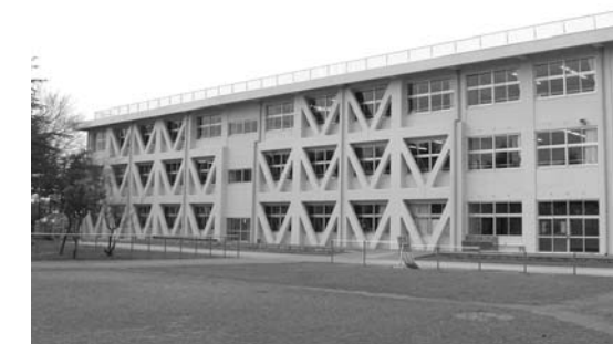
▲三国西小学校耐震改修
