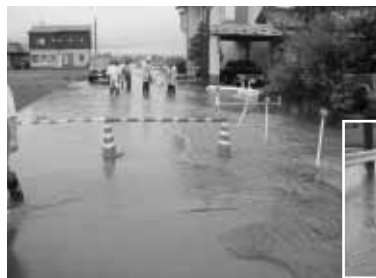
▲中筋北浦 冠水状況
