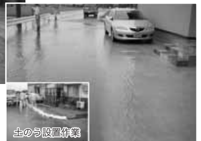
▲中筋 冠水状況
