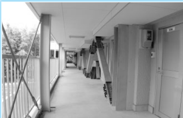
三国立田団地耐震化等工事(192,480千円) 耐震診断により補強された1号棟
