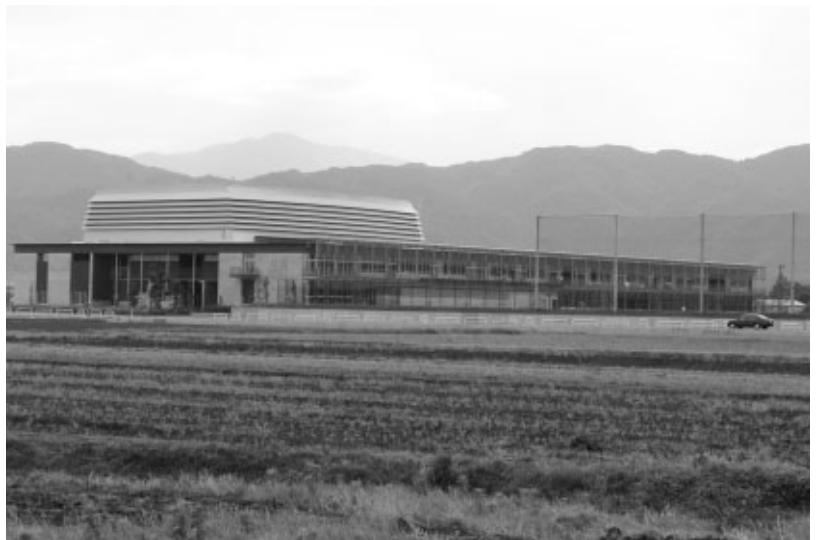
▲ 新設の丸岡南中学校
