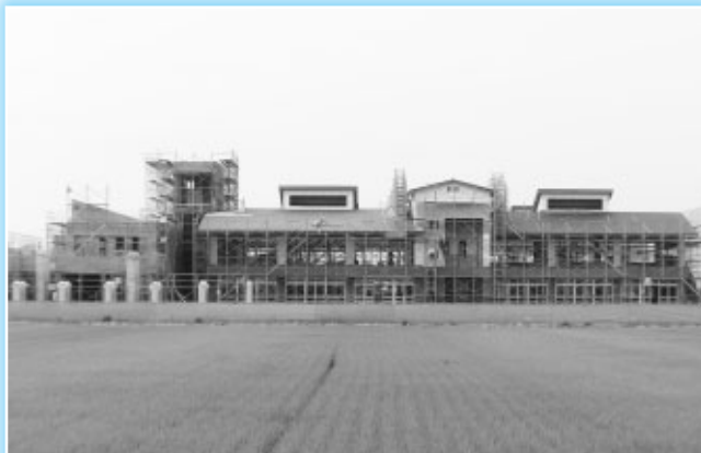
春江東小学校建設事業(1,249,637千円) 19年4月開校目指し、急ピッチで進められている 建設現場
