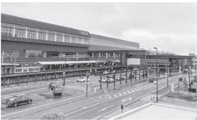
▲令和6年春の北陸新幹線福井・敦賀開業を控え、受入準備の進む芦原温泉駅周辺
