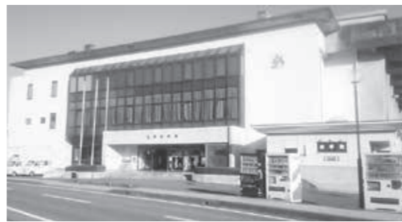
▲今後の動向が注目される丸岡体育館
