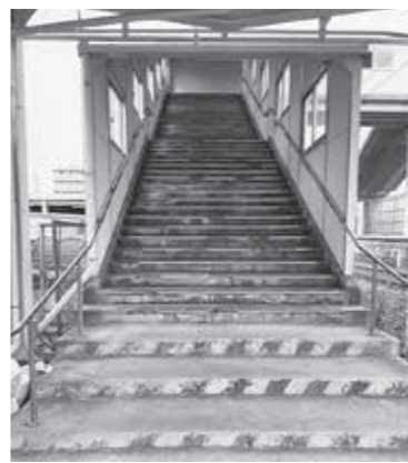
▲エレベーターの設置が望まれるJR春江駅
