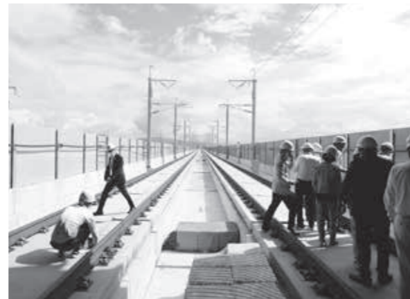
▲ 建設中の北陸新幹線軌道敷見学の様子（9月9日）
