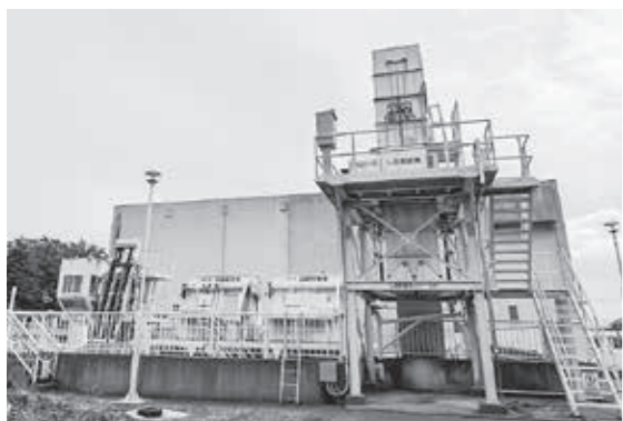
▲三国雨水第1ポンプ場
