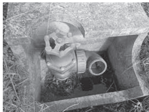
▲水が出なかったパイプラインの給水栓
