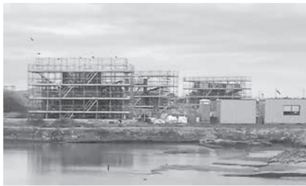
▲ 工事が進む福井港丸岡インター連絡道路(丸岡町舟寄地係)
