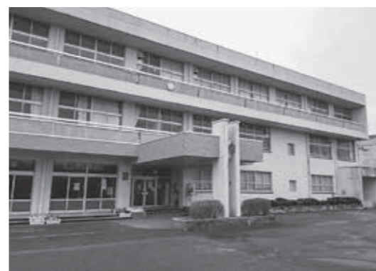
▲ 合併特例債を活用して大規模改修が計画されている雄島小学校
