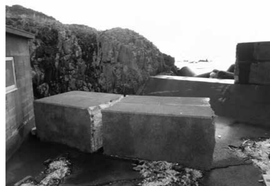
▲高波によって倒壊した安島漁港の防波堤
