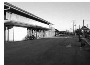
▲三国駅前の状況
