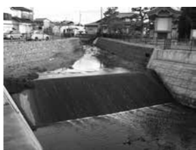
▲上流の改修が望まれる磯部川
