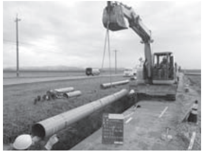
▲ 水道管の耐震化工事の状況
