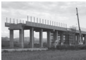
▲工事が進む北陸新幹線(福井市境界地点)
