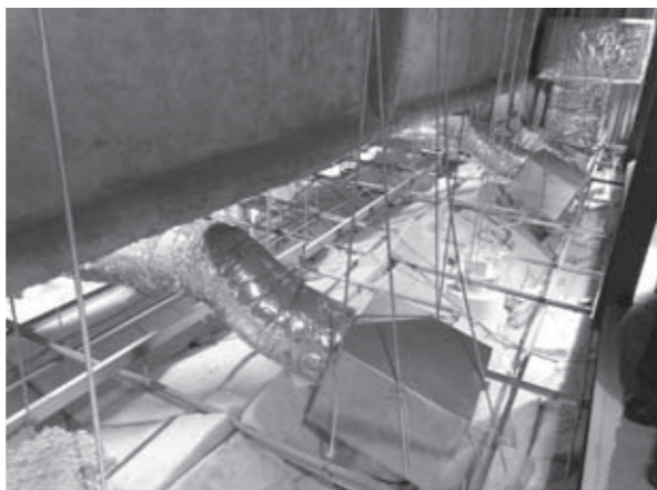
▲耐震工事が予定されているハートピア春江の吊り天井内部
