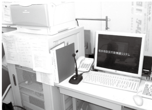
▲防災行政無線自動起動機
