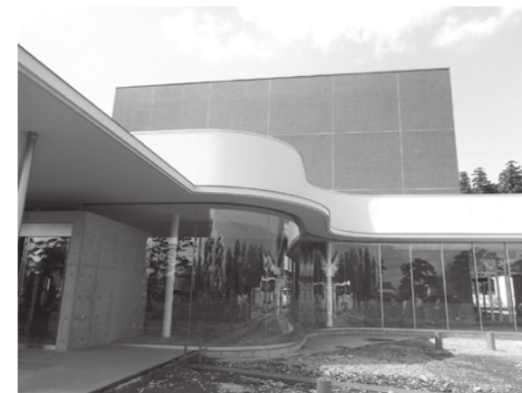
▲現地調査：新築されたみくに市民センター
