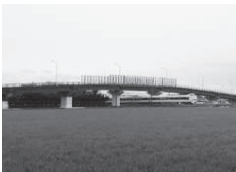
▲ 補修工事が完了した五本跨線橋(市道坂井中央線)
