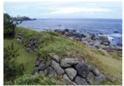
丸岡藩砲台跡全景
