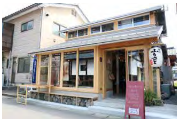
写真 90 城小屋マルコ (丸岡町霞町)
