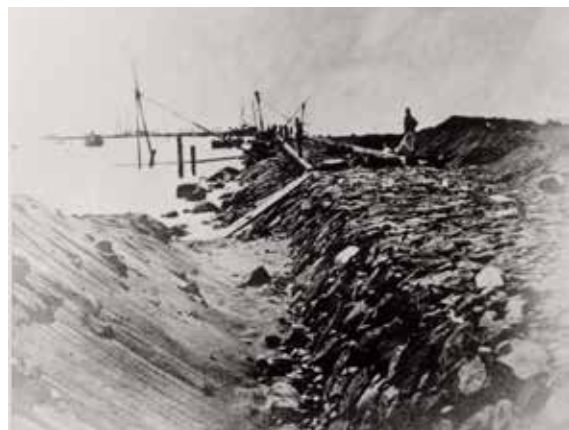
写真 53 三国港 (旧阪井港) 突堤工事の様子
