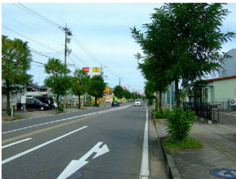
街路樹で道路景観の印象が大きく変わる(都)嶺北縦貫線
