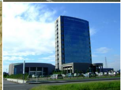
周辺の田園的景観との調和が望まれる大規模建築物
