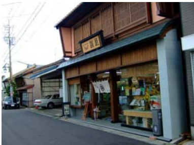
歴史的な街なみ景観に配慮した店舗の改修
