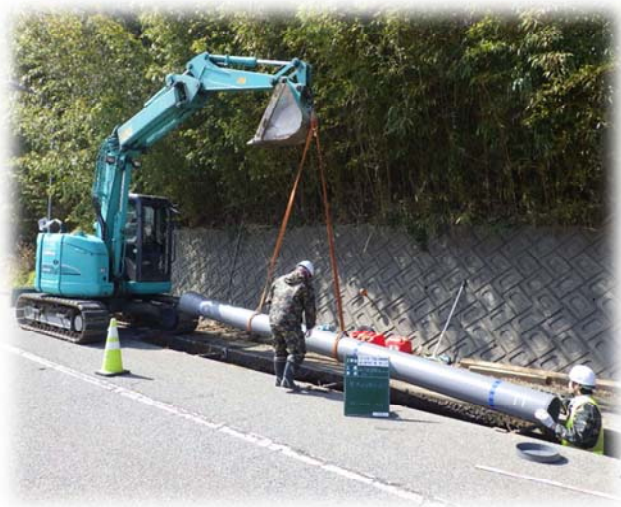
◆管路布設の様子
