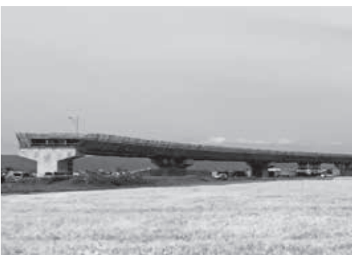
▲ 建設工事中の福井港丸岡インター連絡道路
