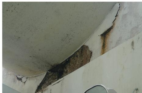
▲老朽化による亀裂や剥離がみられる施設
