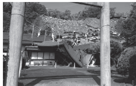
▲平成28年熊本地震の写真
