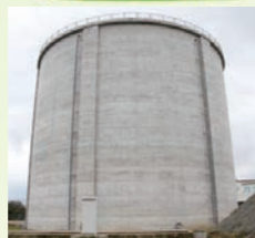
▲調圧水槽の高さに秘密がある・・・
