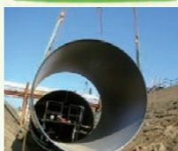
▲シールド工法でなくともこの深さ!
