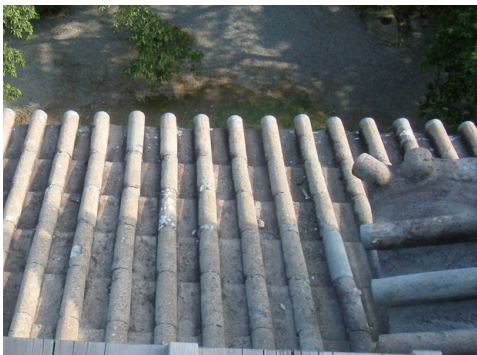
▲身近にある本瓦ぶきの建物・丸岡城天守。全面が平瓦と丸瓦を組み合わせてふいてあるのがわかる
