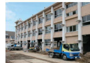
▲坂井中学校の耐震改修工事
