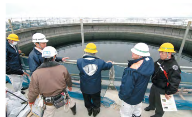
▲30mの高さ、3万トンの水が充填された調圧水槽。冷涼な九頭電川の水を坂井平野に供給
