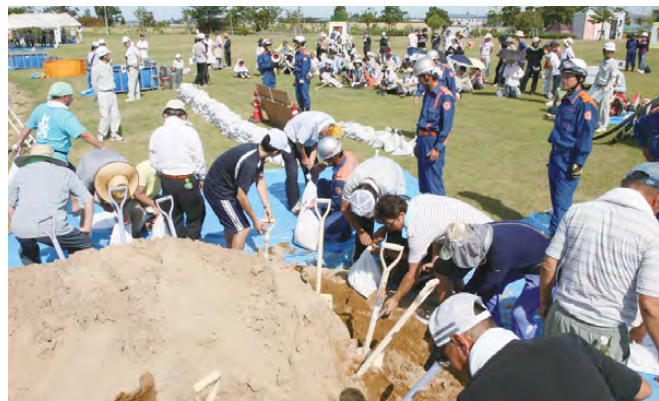
▲堤防の決壊などによる浸水を防ぐ水防工法訓練
