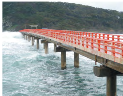
◀架設から28年が経過し、潮風にさらされ傷みの激しい雄島橋
