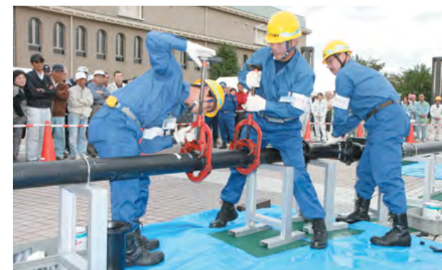
▲地域住民が見つめる中、破損した水道管の組み換えを行う名古屋市の水道局職員
