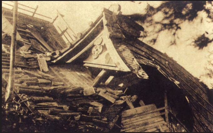
▲崩れ落ちた丸岡城天守閣(写真『重要文化財丸岡城天守修理工事報告書』より)
