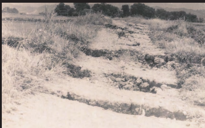
▲東十郷村御油田西側道路の激しい地割れ(写真提供 福井地方気象台)
