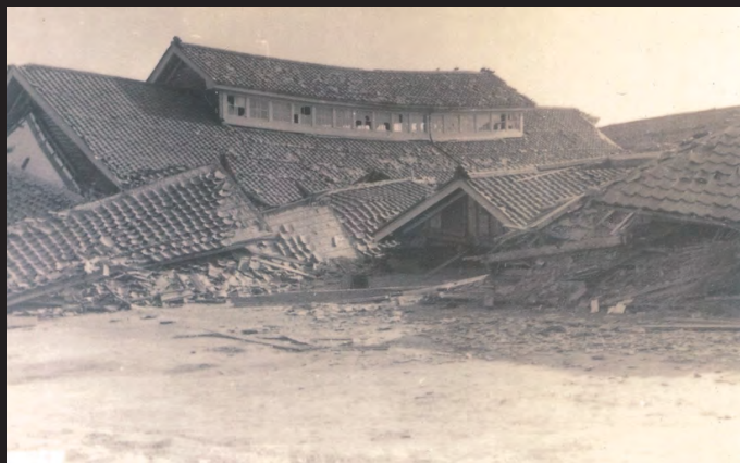
▲倒壊した長畝小学校の校舎(写真提供 福井地方気象台)
