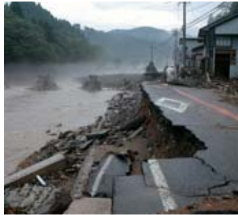
▲崩れ落ちた道路
