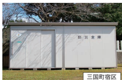
▲設置された防災備蓄倉庫
