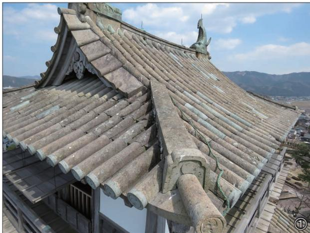
①石瓦が葺かれた丸岡城天守の屋根。現在笏谷石製の瓦は全体の2割以下
