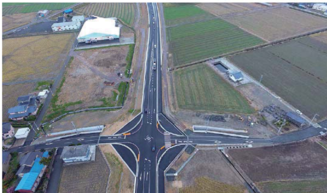
国道8号の4車線化
