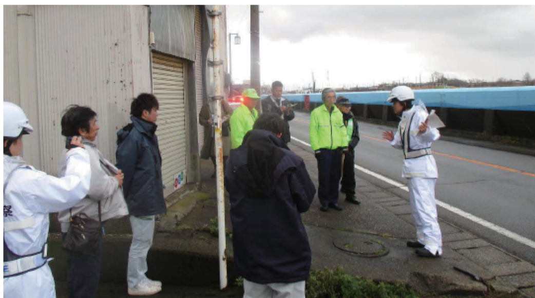
道路状況の現場点検
