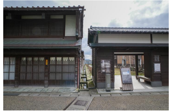
門の設置により小屋根を連続させている
