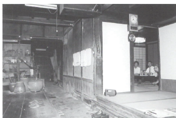
改修前の旧岸名家の通り庭の様子
