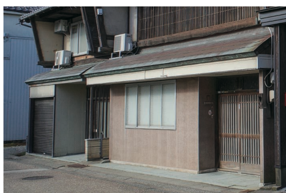
⑦ 同じ小屋根が連続する町並み
