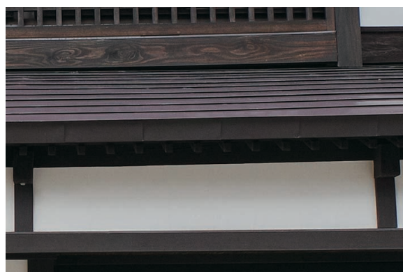
③ ガルバリウム鋼板段葺の小屋根
