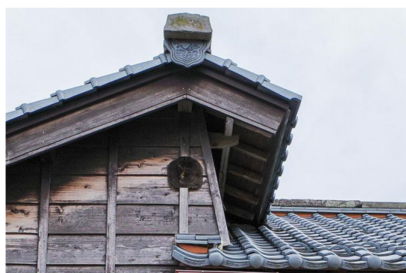
② 銀鼠色の瓦と笏谷石の棟瓦の組み合わせ
