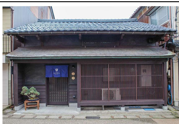
④ 格子を用いて設備機器を隠している例
