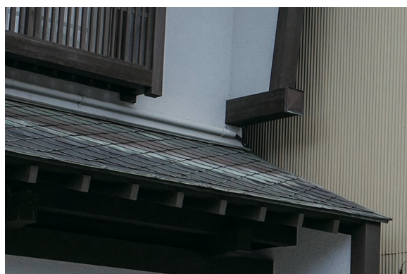
⑤ 直線状の菱葺銅板の小屋根
