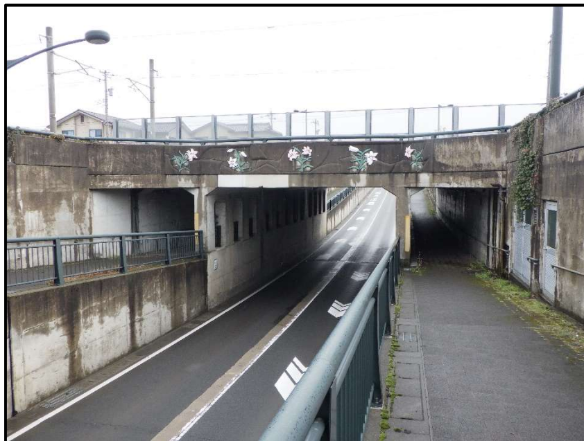
写真 2.2-1 春江1号カルバート全景（起点側より）
