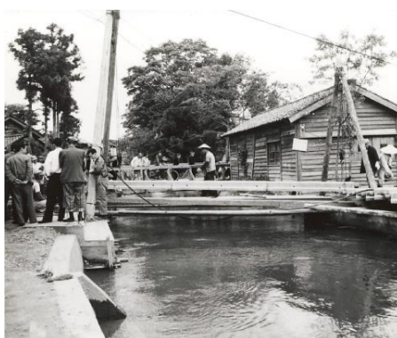
架設作業の様子 (株式会社日本ピーエス HP より)
