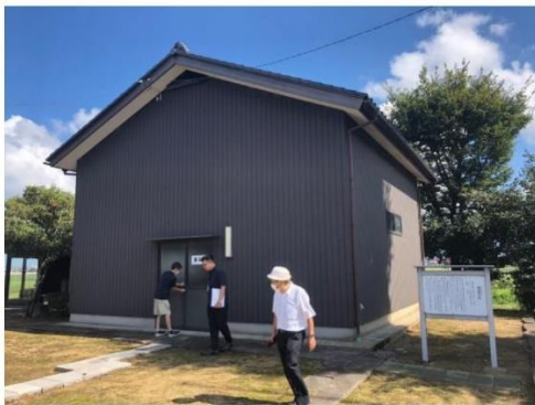
八幡神社境内の門収蔵倉庫外観
