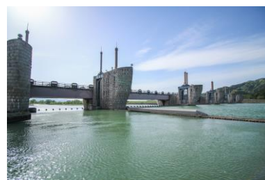
現在の九頭竜川鳴鹿大堰
