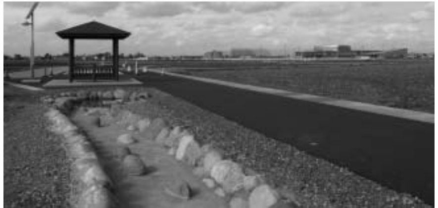
▲パイプライン上部
