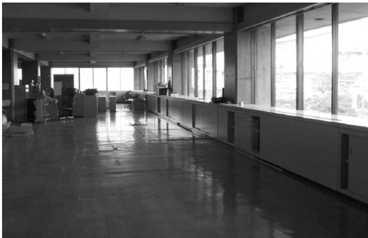
▲総合支所空きスペース
