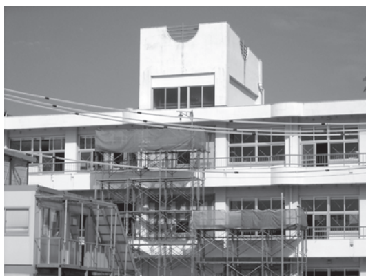
▲東十郷小学校改修工事
