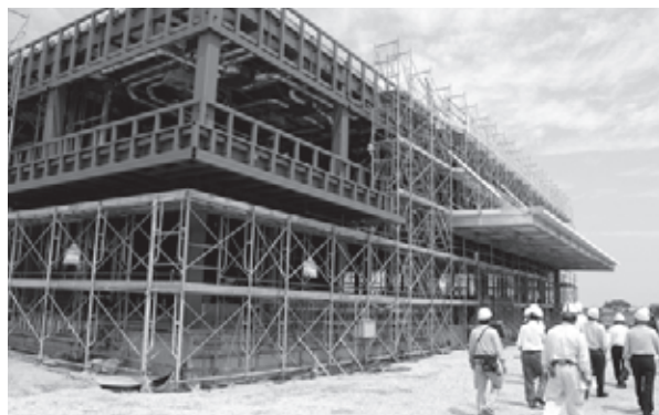
▲建設中の春江坂井学校給食センター(6月24日視察)
