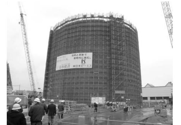
▲十郷用水水路調圧水槽建設現場
