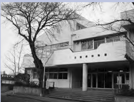
▲耐震診断が行われる三国南幼稚園
