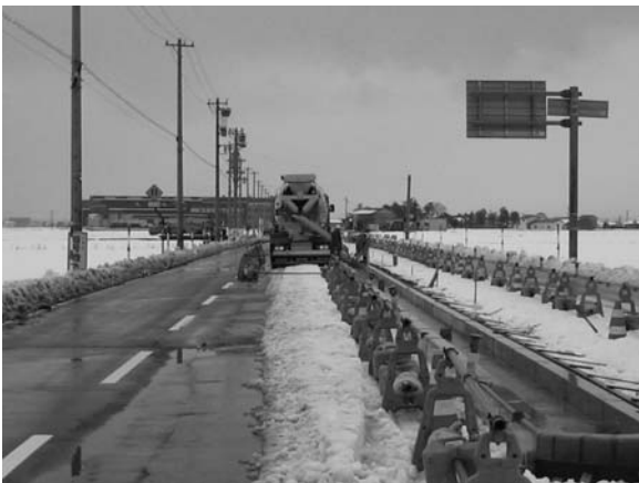
▲県道三国・春江線拡幅工事
