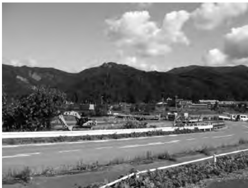
▲鳴鹿大堰(右岸)
