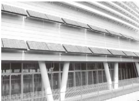
▲ソーラーパネル（丸岡南中学校）
