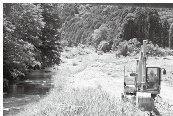
▲整備がすすむ竹田川河川敷（丸岡町川上橋下流）
