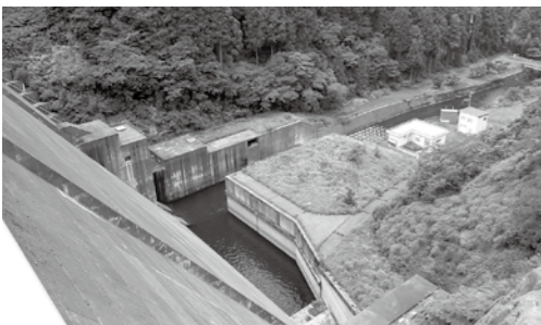
▲龍ヶ鼻ダムと山口発電所
