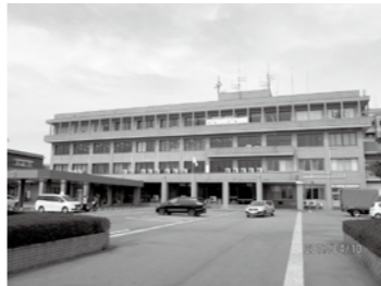
▲坂井市役所春江支所
