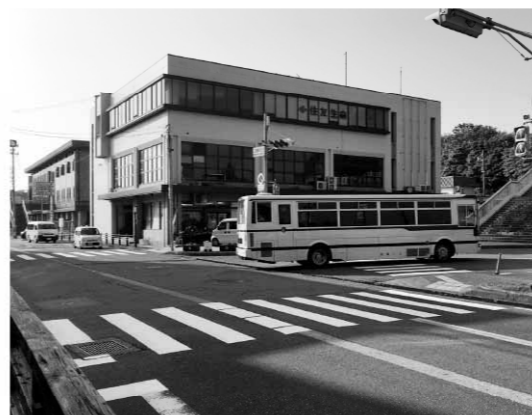
▲整備が今後進められる三国駅舎
